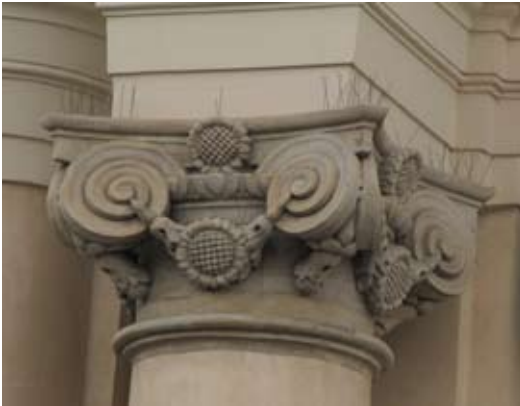
Il. 49. Warszawa, kościół wizytek, elewacja, fragm., kapitel joński I kondygnacji. Stan w 2016 r.
