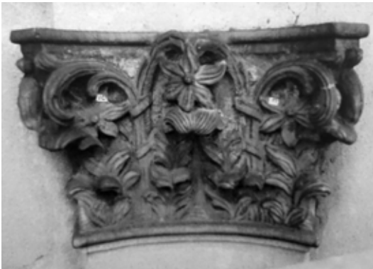
Il. 51. Warszawa, kościół wizytek, elewacja, fragm., kapitel pseudokoryncki III kondygnacji. Stan w 2016 r.
