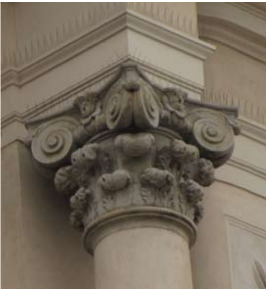
Il. 50. Warszawa, kościół wizytek, elewacja, fragm., kapitel kompozytowy II kondygnacji. Stan w 2016 r.
