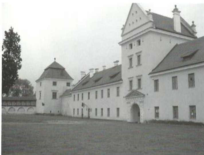
23. Zamek w Żółkwi. Skrzydło bramne. Elewacja od miasta. Stan w 2007. Fot. Autor.
