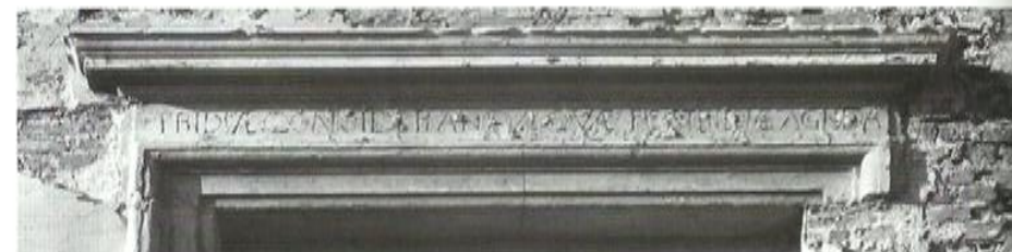
43. Zamek w Żółkwi. Inskrypcja nad oknem „D” elewacji pałacu od ogrodu. Stan w 2007. Fot. Autor.
