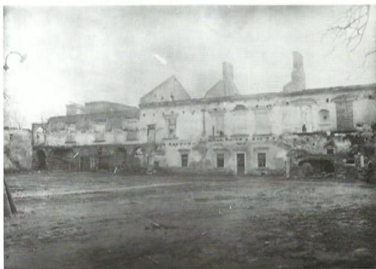
14. Zamek w Żółkwi. Widok na część elewacji pałacu od dziedzińca. Fot. z ok. 1915. Ze zbiorów PRHAŻ.
