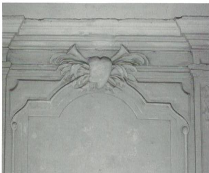
31. Zamek w Żółkwi. Zwieńczenie kominka (od strony ogrodu), w sali jadalnej na piętrze. Stan w 2007. Fot. Autor.
