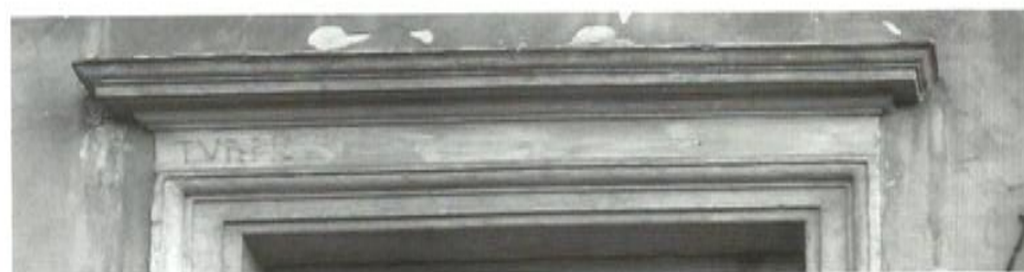
51. Zamek w Żółkwi. Inskrypcja „M” nad oknem frontowej elewacji pałacu. Stan w 2007. Fot. Autor.
