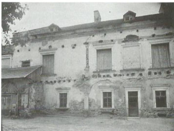
5. Zamek w Żółkwi. Widok na południową część elewacji pałacu od dziedzińca. Fot. z 1892. Ze zbiorów PRHAŻ.
