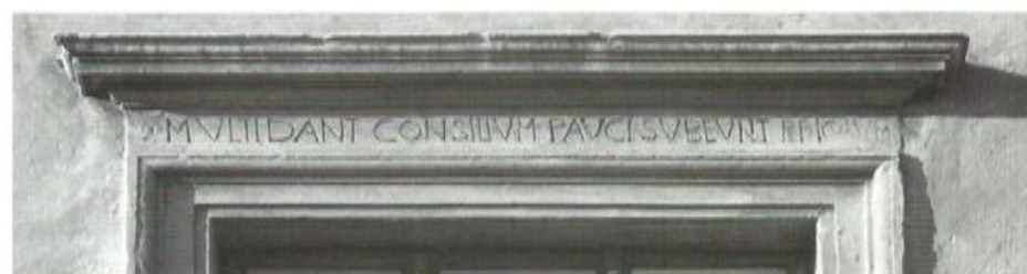
41. Zamek w Żółkwi. Inskrypcja nad oknem „B” elewacji pałacu od ogrodu. Fot. Stan w 2007. Autor.
