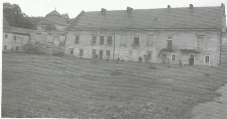
27. Zamek w Żółkwi. Widok na elewację pałacu od dziedzińca. Stan w 2007. Fot. Autor.
