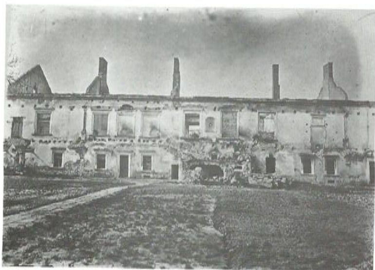
15. Zamek w Żółkwi. Widok na środkową część elewacji pałacu od dziedzińca. Fot. z ok. 1915. Ze zbiorów PRHAŻ.
