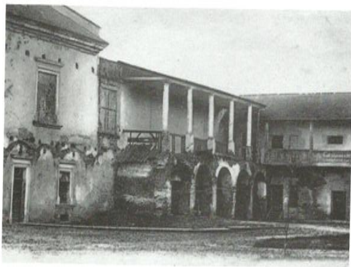
8. Zamek w Żółkwi. Widok na północną część elewacji pałacu od dziedzińca. Kartka z 1905. Ze zbiorów PRHAŻ.
