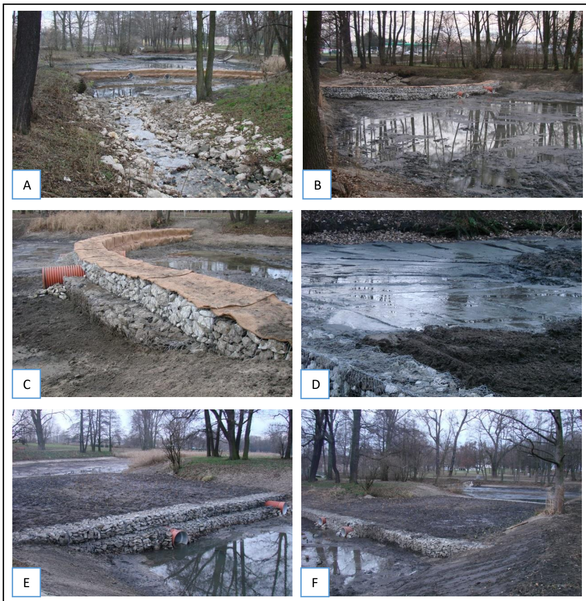
Ryc. 6. Efekty inwestycji prowadzonych w czaszy zbiornika Stawy Jana w grudniu 2015 roku: A- narzut kamieni konstrukcyjnych w korycie rzeki Olechówki; B- strefa pomiędzy pierwszą a drugą linią gabionów; C- pierwsza linia gabionów okryta matą kokosową; D- wypełnienie stref biofiltracyjnych; E- strefa biofiltracyjna południowa; F- strefa biofiltracyjna północna (T. Jurczak, 2015).
