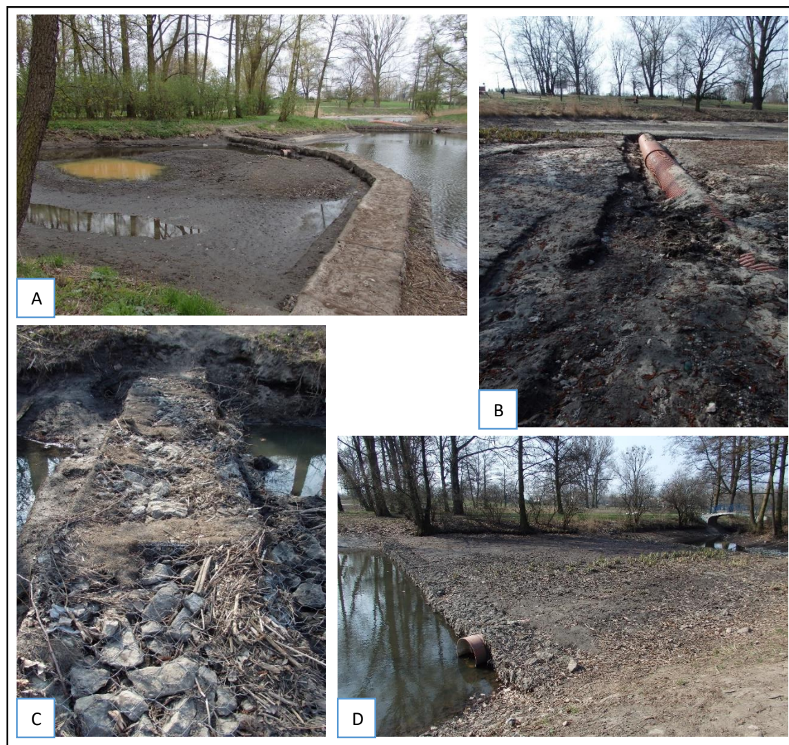
Ryc. 7. Bariera gabionowo-roślinna rok po utworzeniu (Oleksińska, 2017):
