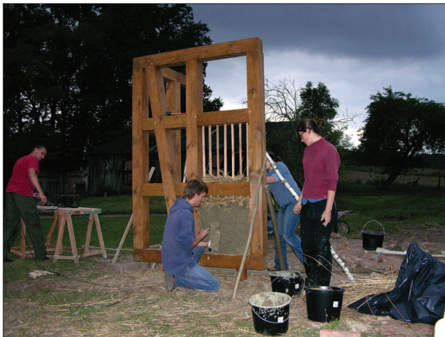
Ryc. 7. Proces powstawania chałupy typu ryglowego (Zdjęcie wykonane na warsztatach Międzynarodowej Konferencji Budownictwa Ryglowego ANTIKON 2009 wyk. M. Rychter)
