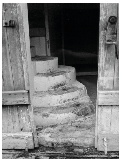
Fot. 15. Schody wewnętrzne synagogi w Szadku, 1987 r.
