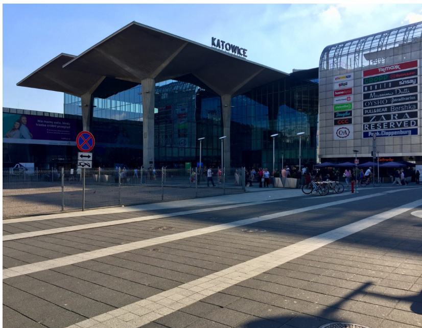
Fotografia 1. Wygląd obecnego dworca w Katowicach
