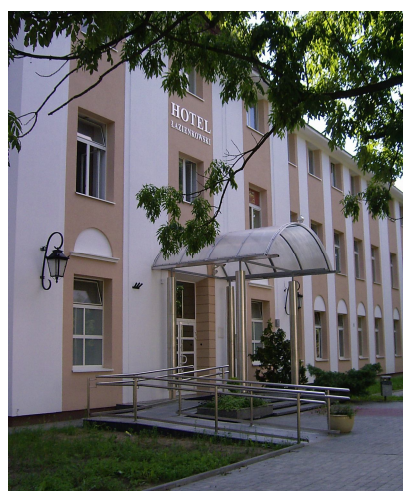
Fot. 6.3. Wejście do hotelu Łazienkowski w Warszawie (Źródło: materiały reklamowe hotelu)
