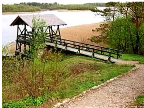
Fot. 6.24. Platforma widokowa we wsi Bryzgiel nad jeziorem Wigry (Źródło: Borejszo 2003)
