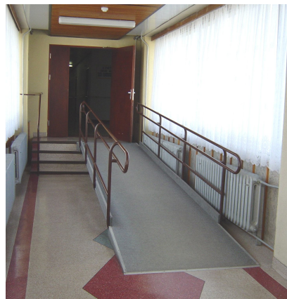
Fot. 6.7. Pochylnia w korytarzu w sanatorium Włókniarz w Busku-Zdroju (Źródło: zbiory autorów)
