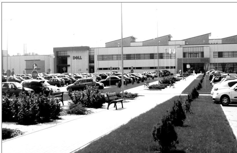
Fot. 1. Zagospodarowanie przestrzeni publicznej w kompleksie przemysłowym ŁSSE Olechów Źródło: E. Gorczycewska (kwiecień 2011)
