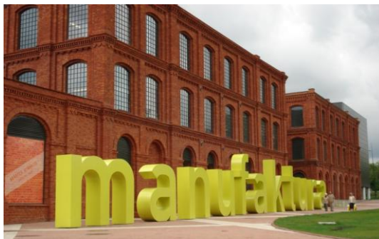
Fot. 2. Manufaktura od strony ulicy Zachodniej (fot. autor) Photo 2. Manufaktura, view from Zachodnia Street (photo author)
