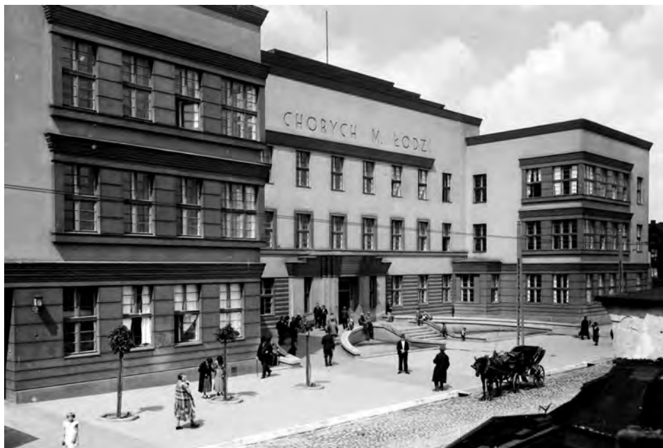
Il. 11. Szpital Kasy Chorych przy ul. Łagiewnickiej – widok ogólny, arch. H. Hirszenberg, Witold Szereszewski (?). Fot. archiwalna ze zbiorów Archiwum Państwowego w Łodzi, Archiwum Włodzimierza Pfeiffera
