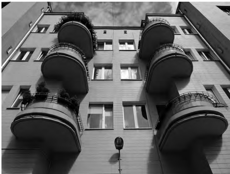
Il. 36. Dawna kamienica Tomaszowskiej Fabryki Sztucznego Jedwabiu przy ul. Piotrkowskiej 203/205 – fragment elewacji zach., arch. I. Gutman. Fot. K. Stefański
