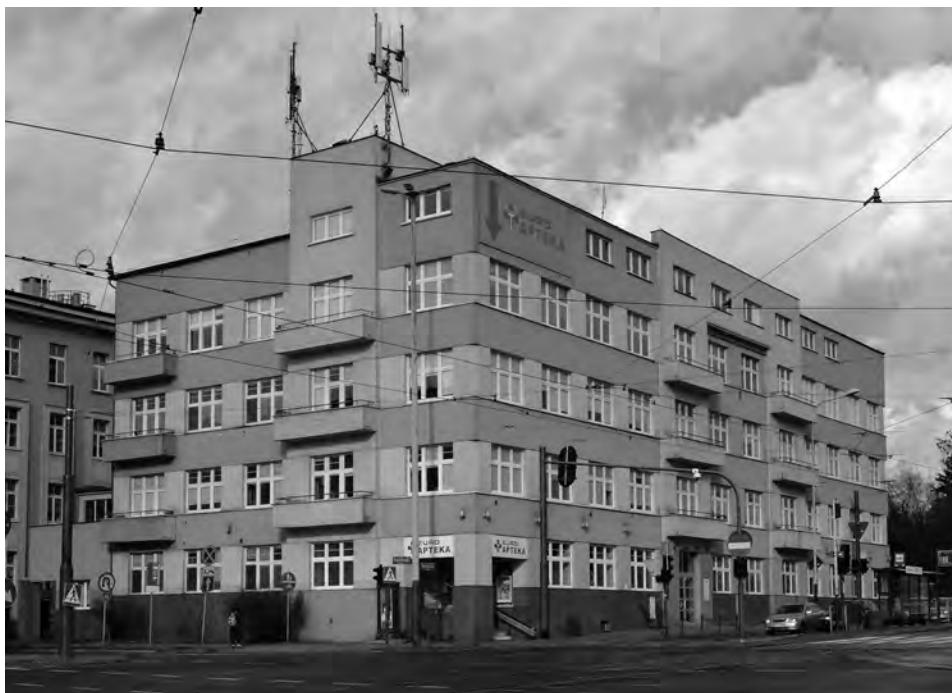
Il. 42. Dawny szpital im. prez. I. Mościckiego (obecnie Uniwersytecki Szpital Kliniczny im. N. Barlickiego) – nowa część od strony pln., arch. H. Goldberg. Fot. K. Stefański
