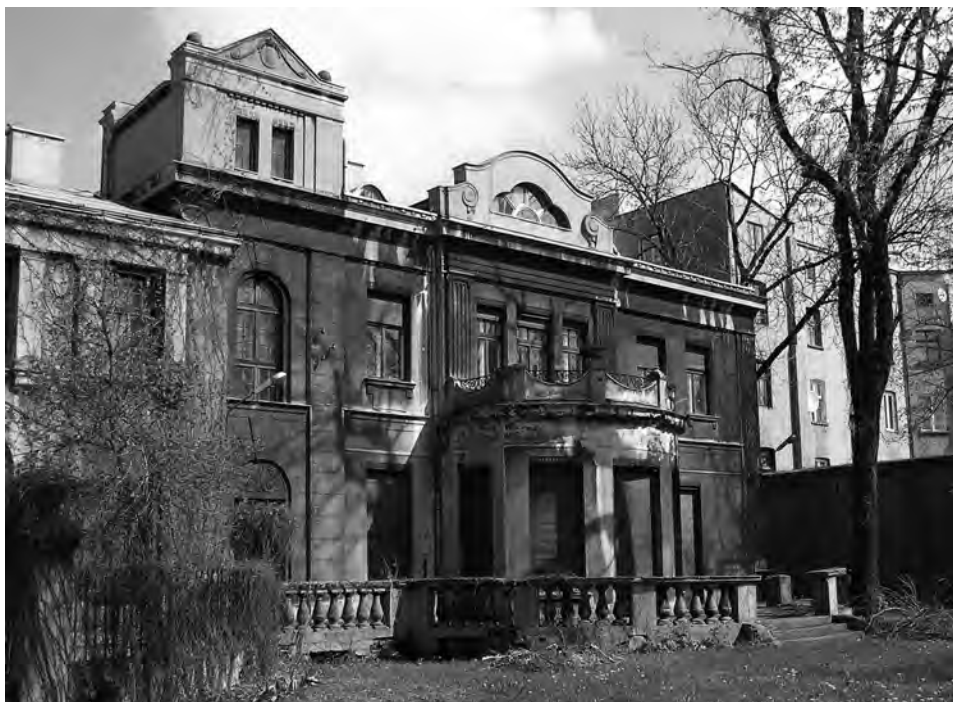
Il. 15. Dawna willa zakładów Leona Allarta przy ul. W. Wróblewskiego – elewacja ogrodowa, arch. Henryk Goldberg. Fot. K. Stefański
