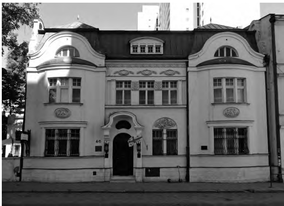
Il. 14. Dawny pałacyk Ignacego Rassalskiego przy ul. S. Wigury 4/6, arch. Leon Lubotynowicz. Fot. K. Stefański
