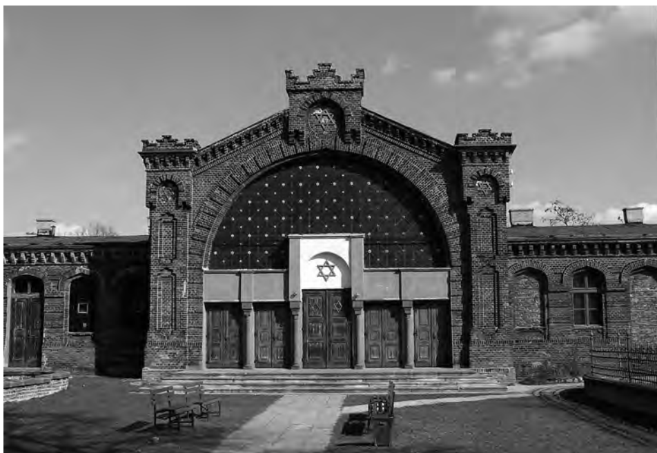
Il. 25. Hala przedpogrzebowa na nowym cmentarzu żydowskim przy ul. Brackiej, arch. A. Zeligson. Fot. K. Stefański
