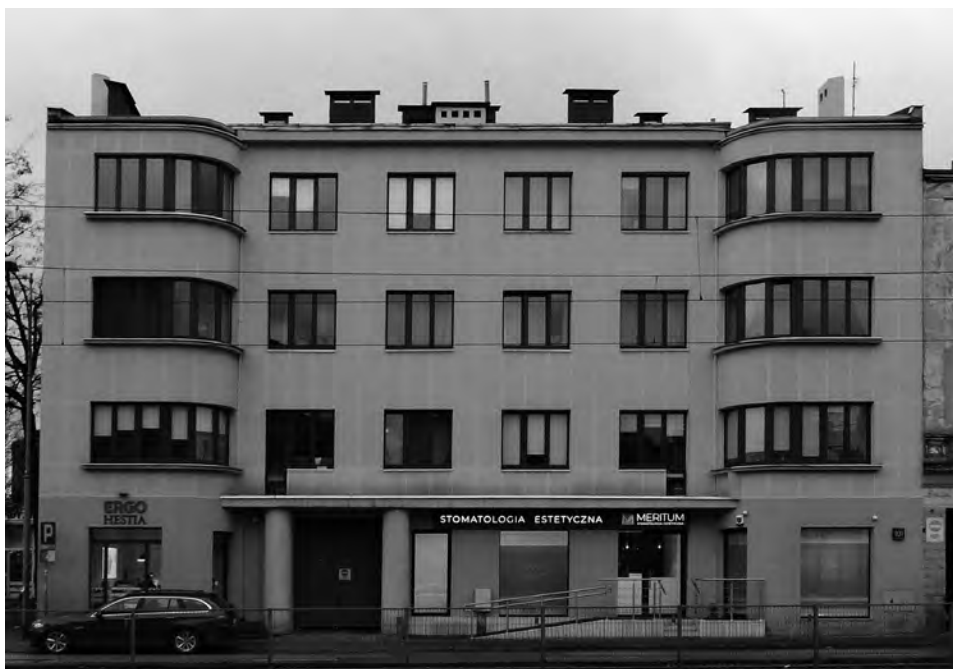
Il. 21. Dawna kamienica Harry’ego Olszera przy ul. Zachodniej 101, arch. H. Hirszenberg. Fot. K. Stefański
