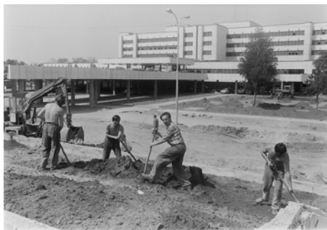
Fot. 113. Robotnicy na budowie CZMP (fot. Janusz Kubik)
