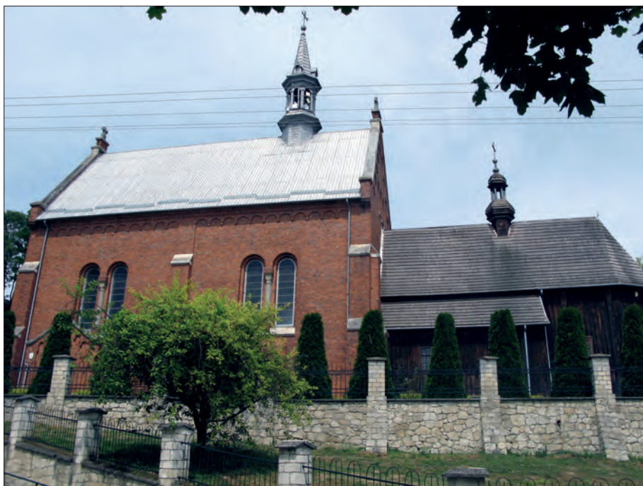
6. Kościół pw. św. Idziego Opata w Zborówku, widok elewacji południowej, fot. D. Rutkowska-Siuda 2015
