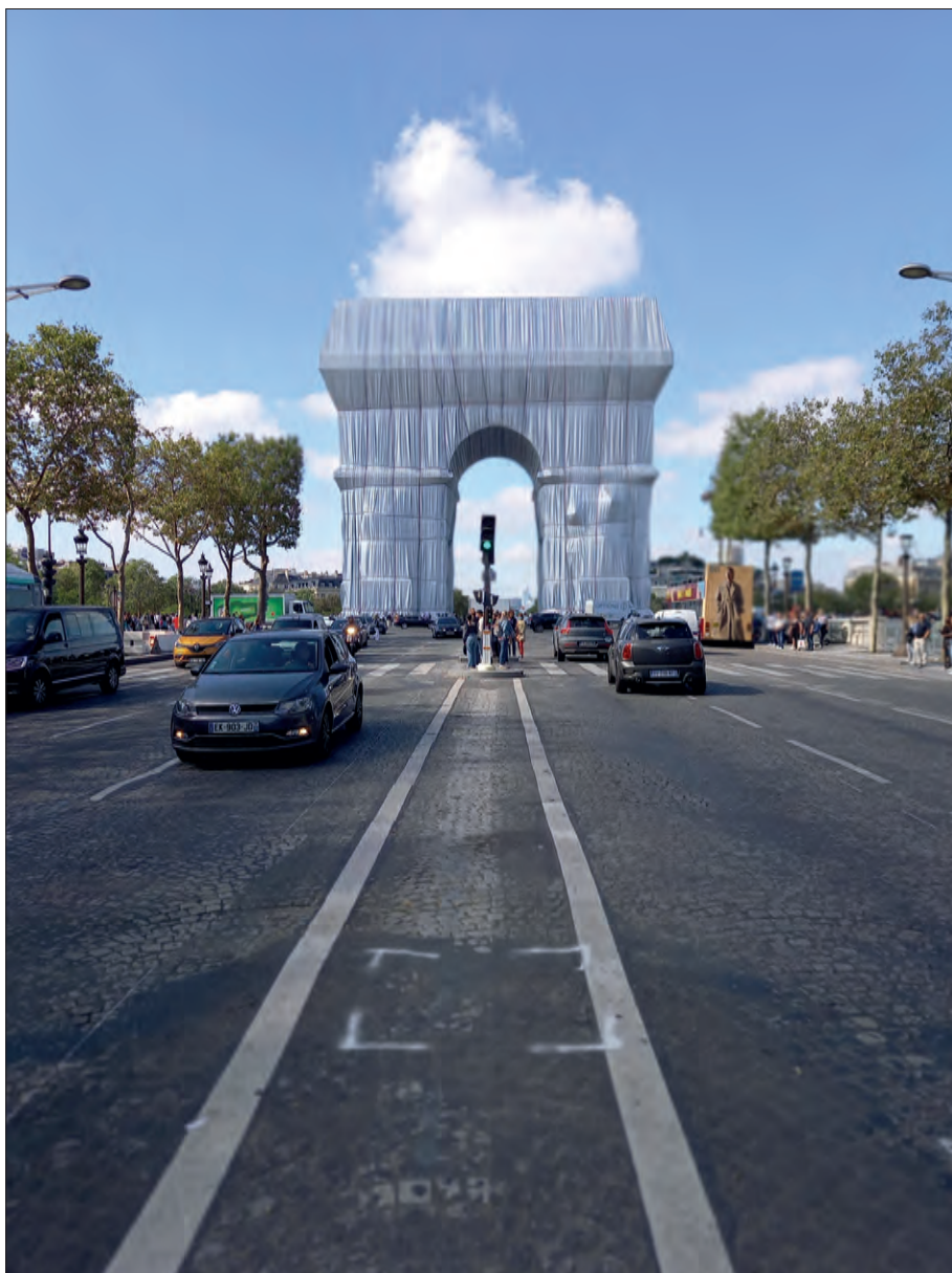
1. Place Christo, Łuk Triumfalny, fot. D. Łarionow
