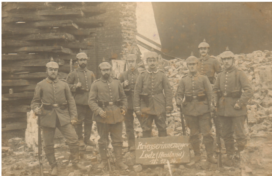
Ryc. 2. Zniszczona wieża ciśnieniowa i żołnierze niemieckiej kompanii inżynierskiej na dworcu Łódź Kaliska, 11 XII 1914 (źródło: APŁ, Zbiór ikonograficzny APŁ, sygn. W-I 5/365)
