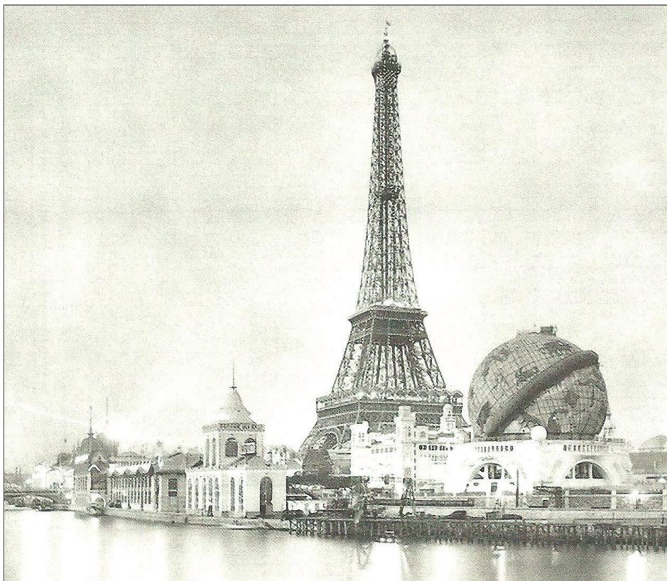
15. Paryż, Wieża Eiffla, 1900. Wieża Eiffla i model kosmosu 53 ; fot. z archiwum autorki
