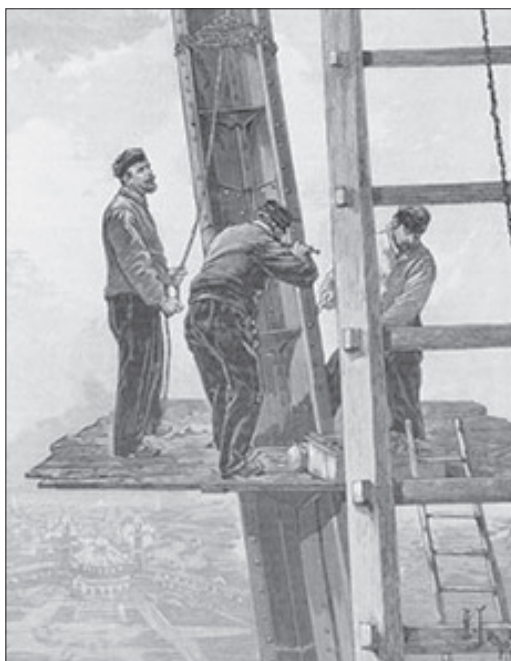
5. N.N., Pierwsze prace przy budowie Wieży Eiffla. Montaż pierwszego piętra , https://www.toureiffel.paris/fr/actualites/130-ans-1889-2019-130-ans-demerveillement ; https://en.wikipedia.org/wiki/Eiffel_Tower#/media/File:Construction_tour_eiffel.JPG
