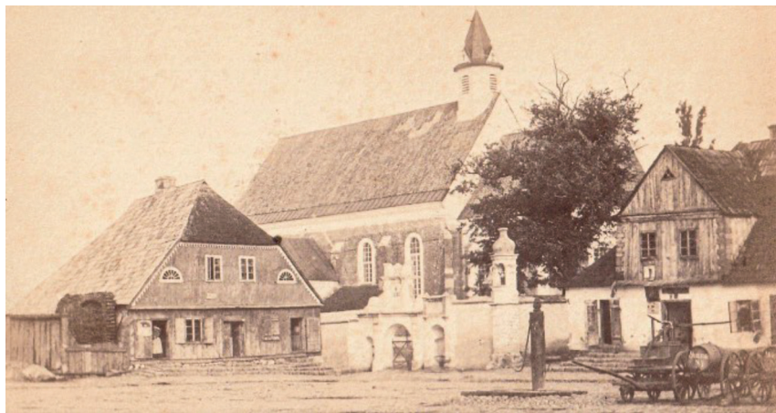
Ryc. 4. Dawny mur obwodowy kolegiaty z furką i kapliczką oraz stare drewniane domy mieszczańskie przy rynku. Widok od strony rynku, ok. 1865 r.
