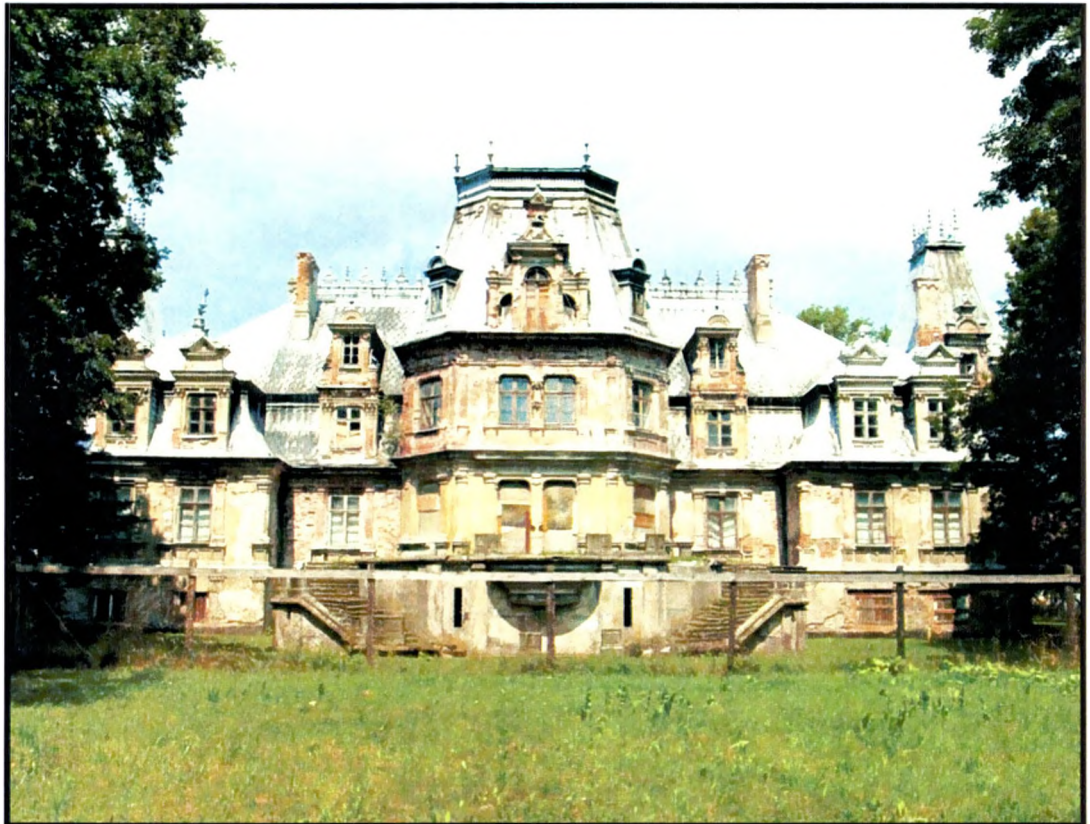
Pałac z lat 80. XIX w. - elewacja od strony ogrodu
