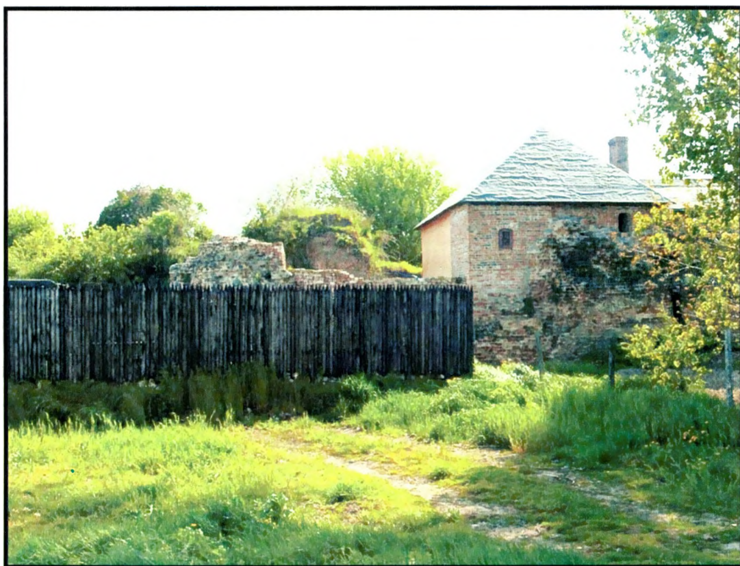
Zamek - odbudowany fragment od strony wschodniej
