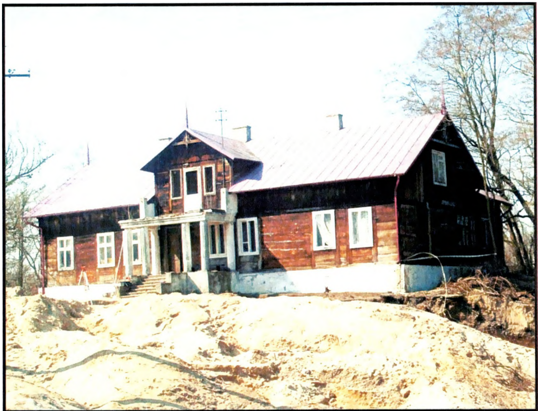
Dwór drewniany z początku XX w. (obecnie nieistniejący)
