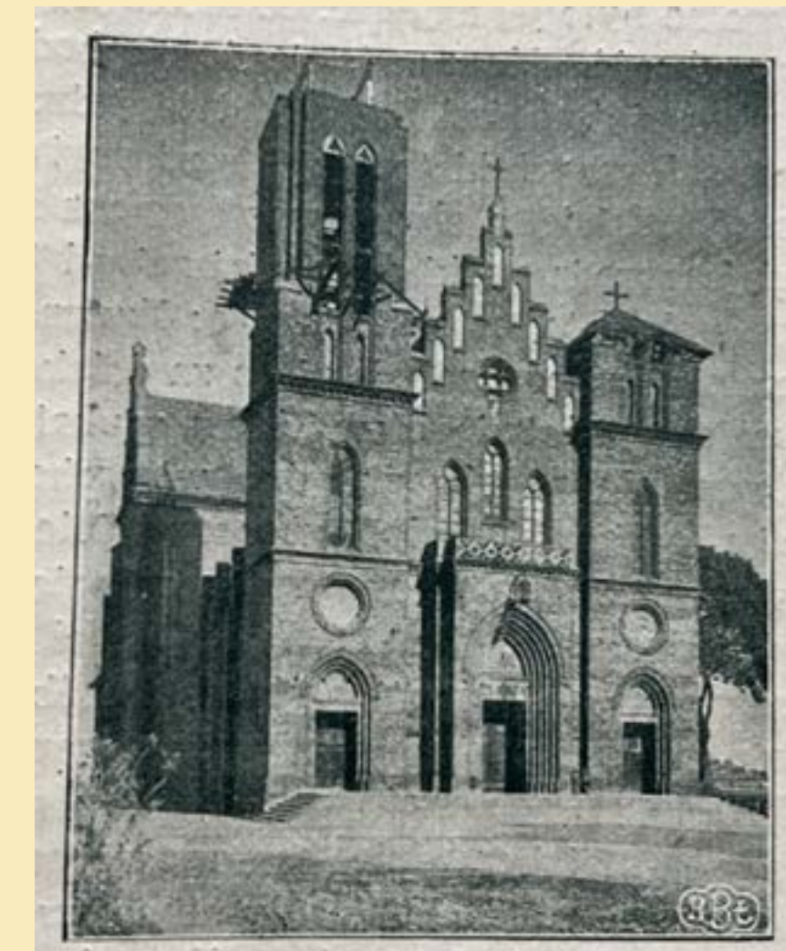
Il. 1. Fasada kościoła w trakcie budowy wież, fot. Włodzimierz Pfeiffer, „Łódź w ilustracji” 1930, nr 44, s. 7.
