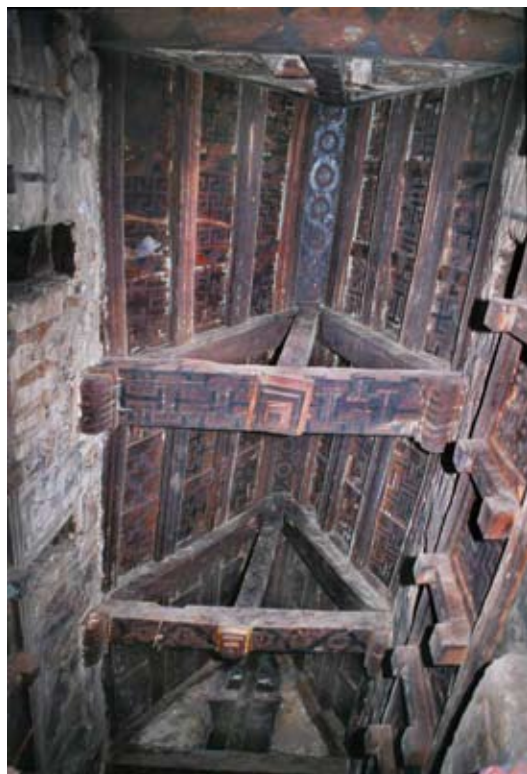
12. Եմակինա Մաճհանե Ալամ church, saddle-back roof over the nave
