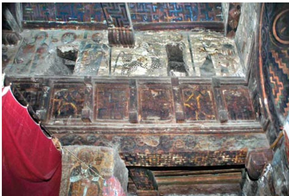
9. Զմակինա Մածինե Ալամ church, northeast corner showing pillar, principal beam, frieze, and clerestory ceiling timbers above the nave
