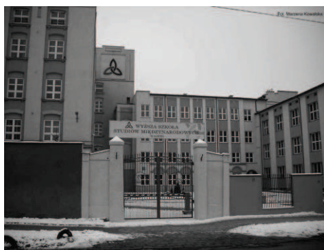
Fot.1. Budynek Wyższej Szkoły Studiów Międzynarodowych przy ul. Brzozowej 5/9
