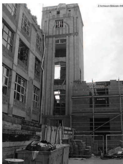
Fot. 5. Remont budynku Biblioteki Akademii Humanistyczno-Ekonomicznej
