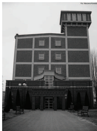
Fot. 10. Budynek Biblioteki Politechniki Łódzkiej po remoncie
