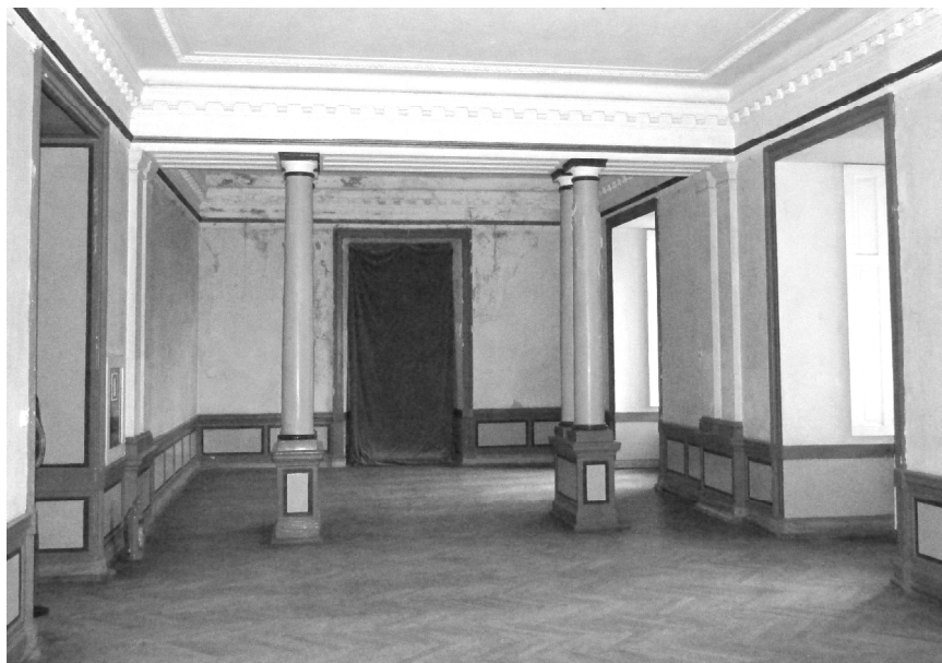
Il. 6. Wnętrze pałacu – parter. Główny hall, fot. A. Barczyk, 2015
