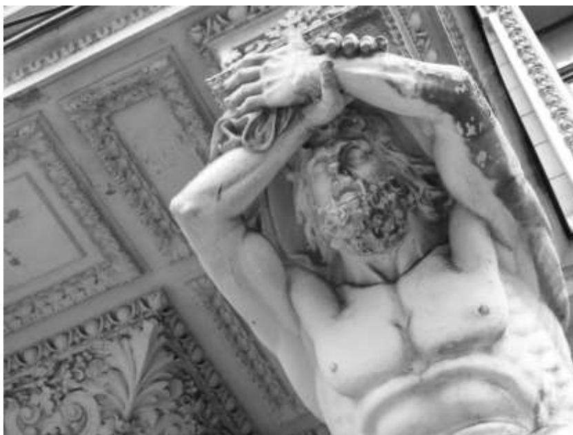
Ryc. 2. Front jednej z kamienic i postać muskularnego mężczyzny (Atlant) podtrzymującego strop (fot. R. Dzięcielski)
