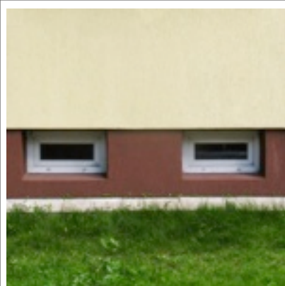
zakrycie wątku ceglanego warstwą styropianu po termomodernizacji
