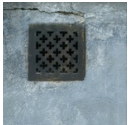
oryginalne wywietrzniki pod otworami okiennymi
