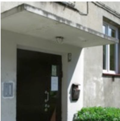
oryginalny daszek nad wejściem do klatki schodowej
