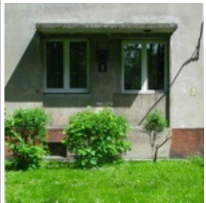
zastąpienie otworu drzwiowego otworem okiennym
