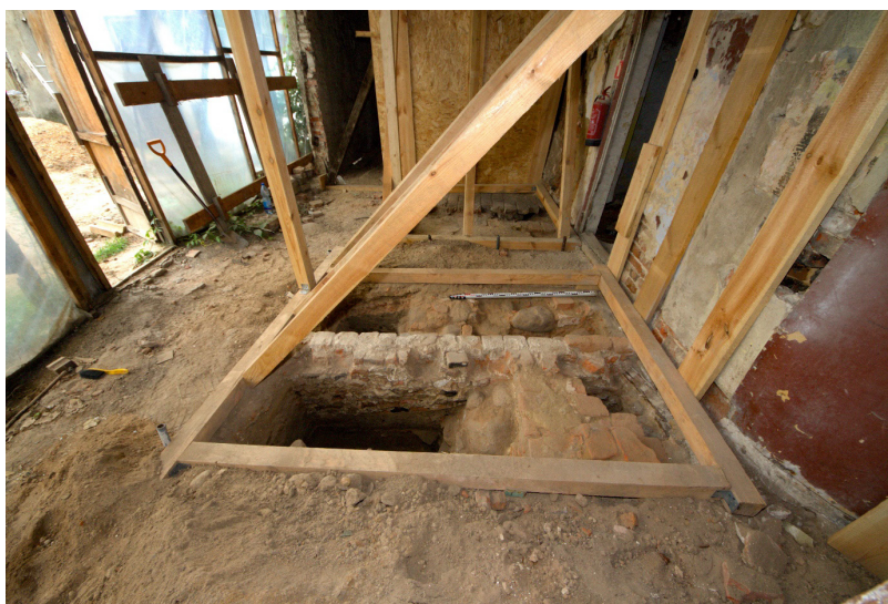
Ryc. 6. Wykop 38. Na zdjęciu relikty fundamentu klatki schodowej, kominka oraz wymurowanej na nich XIX-wiecznej ściany działowej. W obrębie niewidocznego północnego profilu znajduje się fundament pierwotnej ściany magistralnej zamykającej od północy zachodnie skrzydło pałacowe. Widok w kierunku południowym. Fot. A. Ginter
