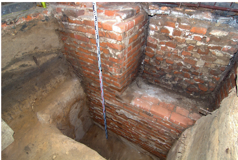
Ryc. 10. Fundament ryzalitu południowego korpusu głównego pałacu. Widok w kierunku południowo-wschodnim. Fot. A. Ginter
