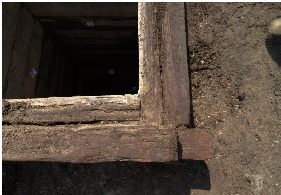
Ryc. 19. Studnia nr 1. Wyraźnie widoczne dwie warstwy konstrukcyjne – zewnętrzna i wewnętrzna. Fot. A. Ginter
