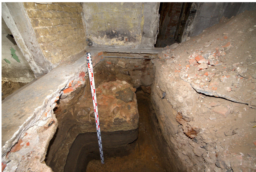
Ryc. 8. Fundament jednego z pieców wschodniego skrzydła postawiony bezpośrednio na warstwach o XVI-wiecznej metryce. Widok w kierunku północnym. Fot. A. Ginter
