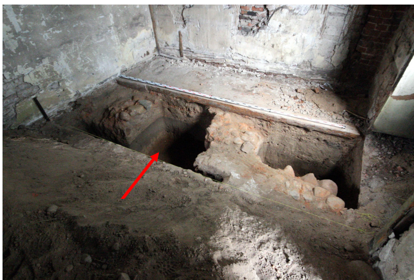
Ryc. 5. Odkryte w pomieszczeniu 1 kamienno-ceglane relikty fundamentów kaplicy pałacowej. Czerwoną strzałką oznaczono miejsce funkcjonowania niewielkiego, orientowanego prezbiterium, które widoczne jest na planie J.M. Walthera. Widok w kierunku wschodnim. Fot. A. Ginter
