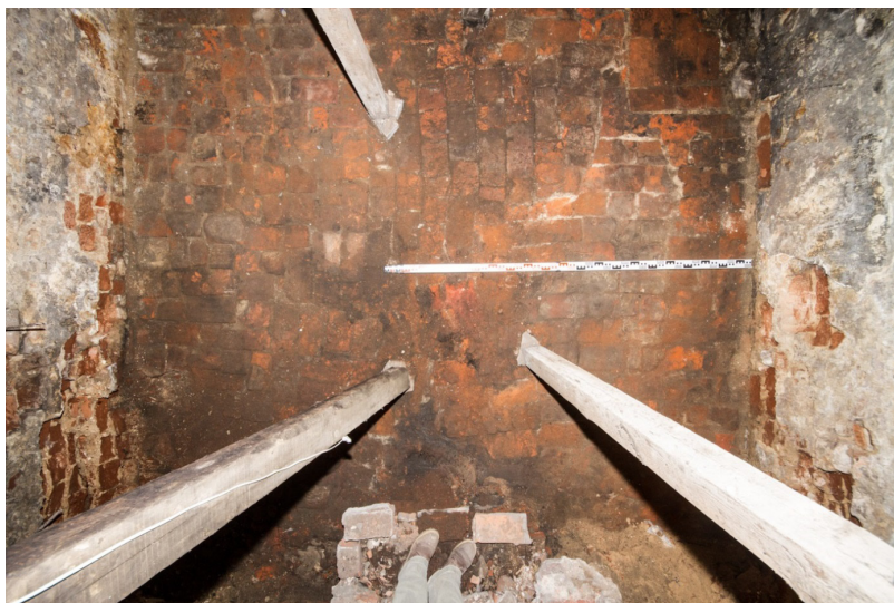
Ryc. 7. Posadzka piwnicy zachodniego skrzydła. Fot. A. Ginter
