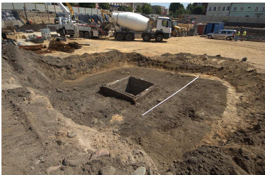
Ryc. 21. Studnia 1 wraz z otaczającym ją wkopem budowlanym. Fot. A. Ginter
