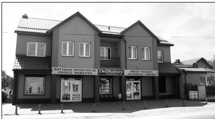
Fot. 9.1. Budynek mieszkalno-usługowy tworzący wschodnią pierzeję rynku w Strykowie (zdjęcie: S. Kowara)
