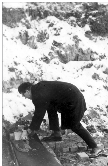
Fot. 69. Pierwsze warstwy muru audytorium gmachu biologii kładzie Eugeniusz Czerniawski (10 grudnia 1966)
