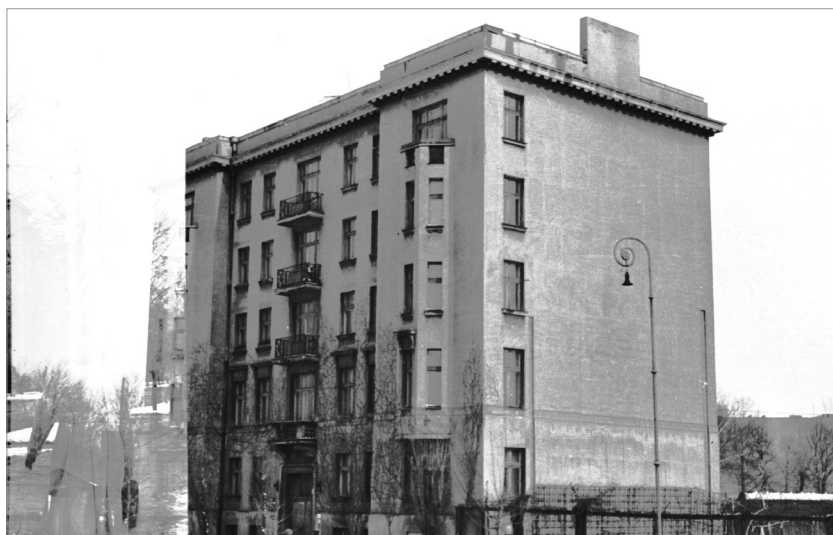
Fot. 65. Budynek przy Uniwersyteckiej 3
