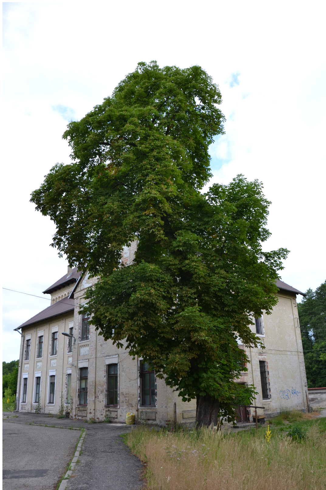
Ryc. 32. Julianka, dworzec; widok od strony południowo-wschodniej; fot. A. Majewska; czerwiec 2017 r.
