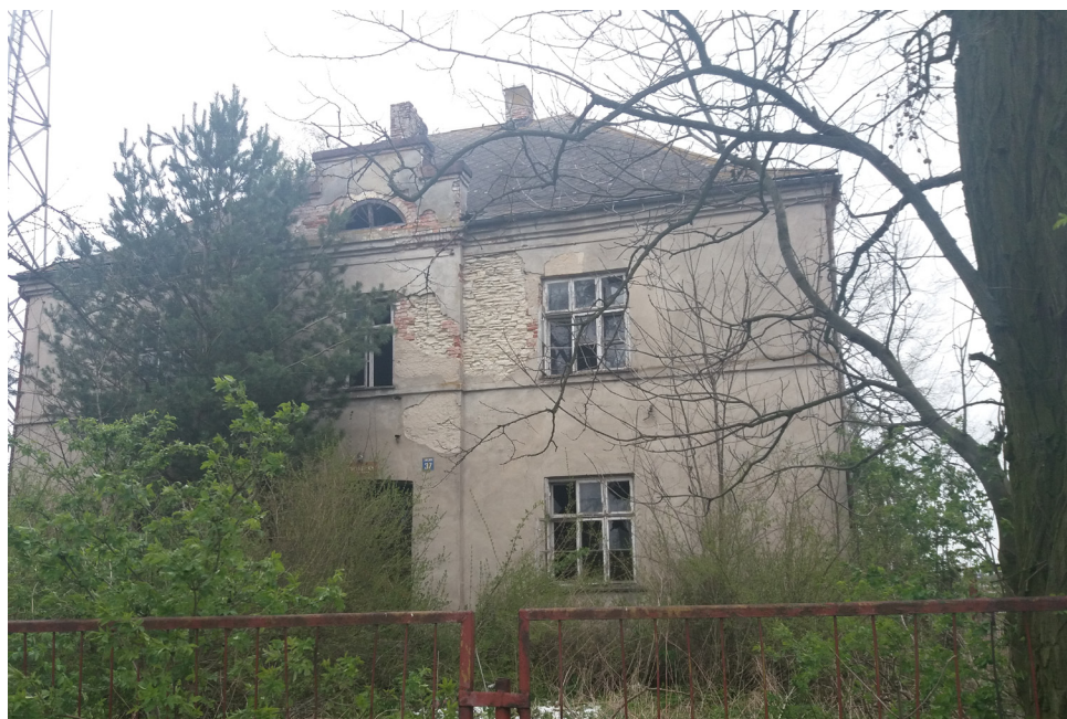
Ryc. 15. Zarębice, dawna szkoła; widok na elewację południową (frontową); fot. W. Kasińska; kwiecień 2017 r.
