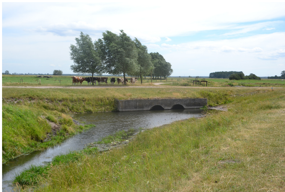
Ryc. 23. Zarębice, Kanał Lodowy; widok wodopoju i przepustów od strony północno-zachodniej; fot. A. Majewska; czerwiec 2017 r.
