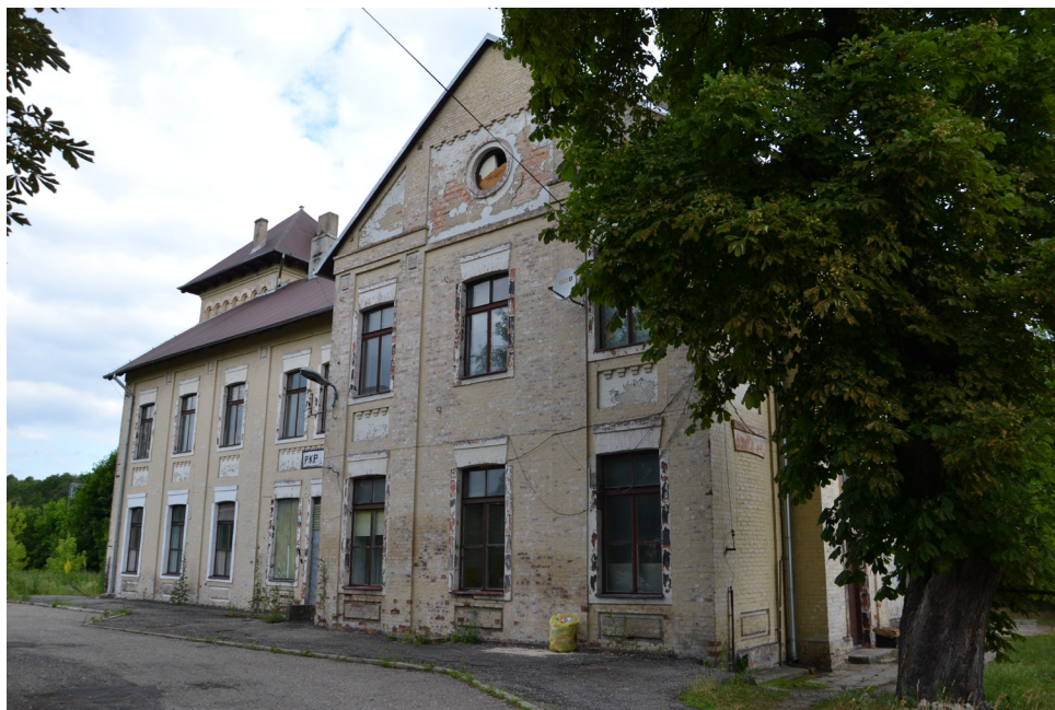
Ryc. 33. Julianka, dworzec; widok od strony południowo-wschodniej; fot. A. Majewska; czerwiec 2017 r.
