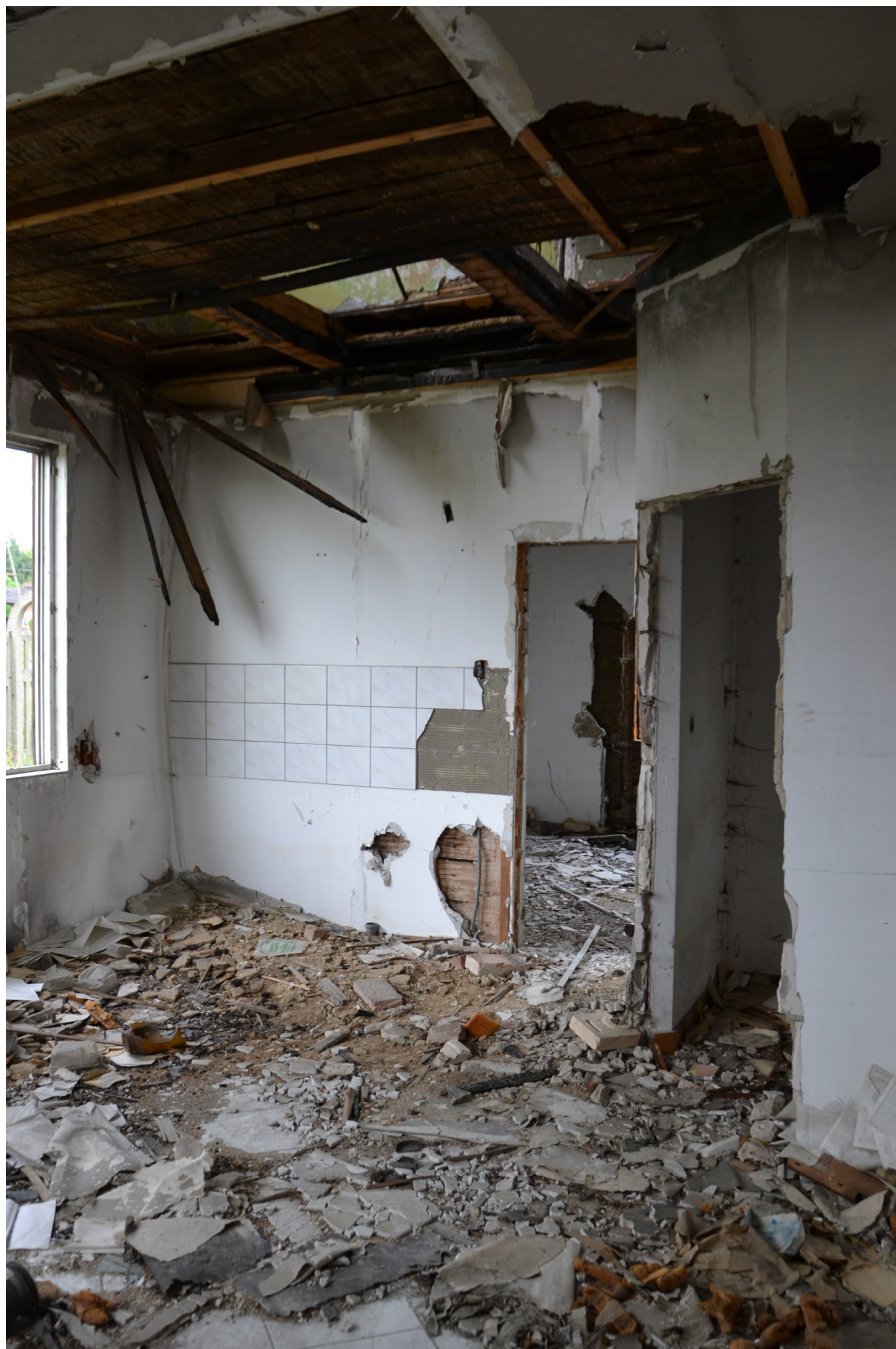
Ryc. 56. Zalesice, młyn; wnętrze; fot. A. Majewska; czerwiec 2017 r.
