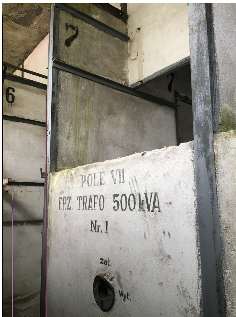
Ryc. 49. Zalesice, syropiarnia; budynek nr 3; wnętrze; fot. A. Majewska; czerwiec 2017 r.
