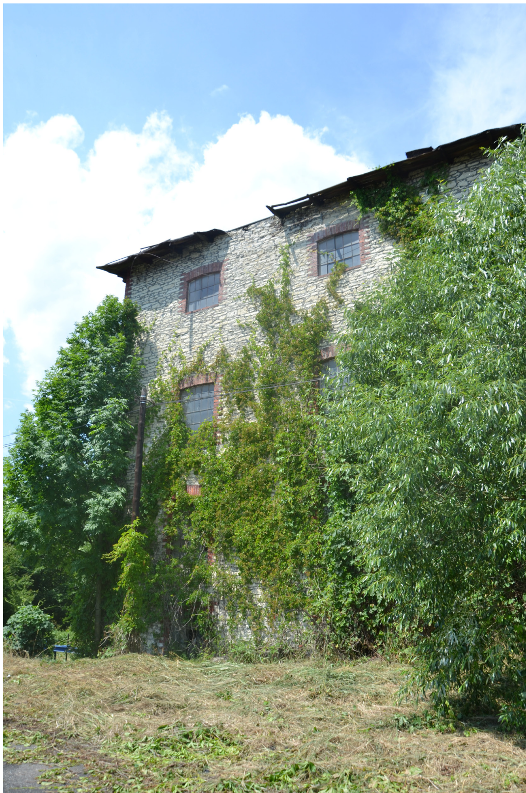
Ryc. 62. Knieja, młyn, budynek główny; widok od strony wschodniej; fot. A. Majewska; czerwiec 2017 r.
