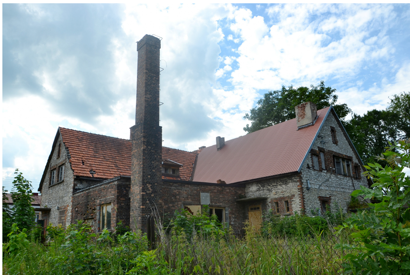
Ryc. 9. Przyrów, dawna piekarnia; widok od strony północno-zachodniej; fot. A. Majewska; lipiec 2017 r.
