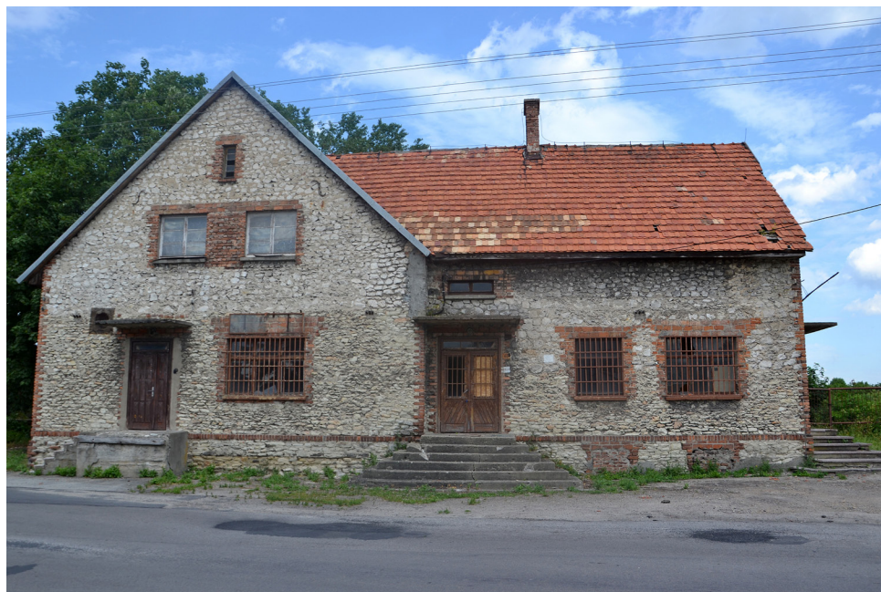
Ryc. 8. Przyrów, dawna piekarnia; widok od strony południowo-wschodniej; fot. A. Majewska; lipiec 2017 r.
