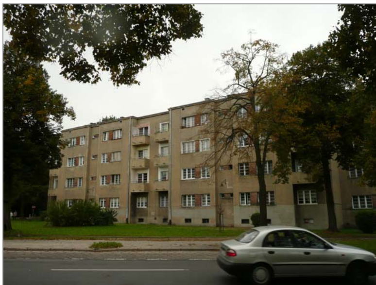
Fot. 1. Budynek przy ulicy Srebrzyńskiej 75 w Łodzi, gdzie mieszkali Strzemińscy
