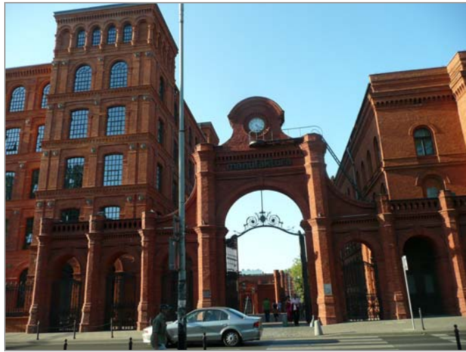
Fot. 6. Wejście do Centrum Rozrywkowo-Handlowego „Manufaktura” w Łodzi
