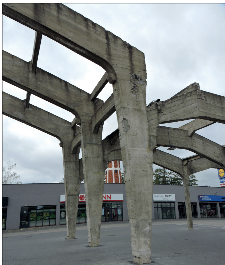
14. Dawne zakłady Towarzystwa John, Krebs i S-ka, później Fakora, hala odlewni w trakcie rozbiórki. Fot. K. Stefański, 2015
