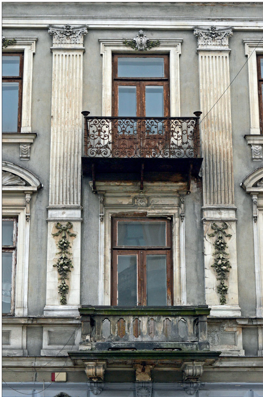
9. Balkony na elewacji kamienicy przy ul. Piłsudskiego 9; rzadziej spotykane zestawienie balkonu żelbetowego (I piętro) i żeliwnego (II piętro); fot. autorka, 2024
