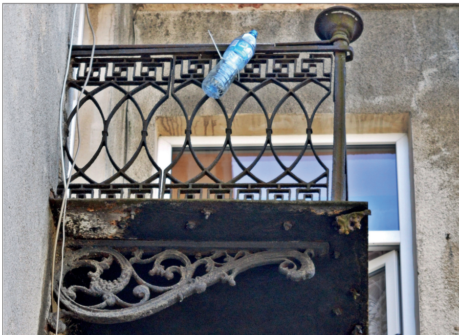
10. Balkon od podwórza przy ul. Piłsudskiego 7 z najpopularniejszym typem wspornika, widok z boku; fot. autorka, 2024
