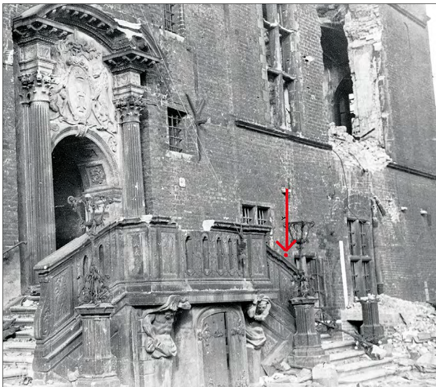
Ryc. 11. Zniszczony w wyniku działań wojennych ratusz Głównego Miasta w Gdańsku. Widoczna wyrwa w murze i zniszczony lampion przy schodach wejściowych. Strzałką zaznaczono miejsce, gdzie powinien być widoczne zadaszanie wzorców miar. Zdjęcie z lat 1945–1946. Źródło: fotopolska.eu.
