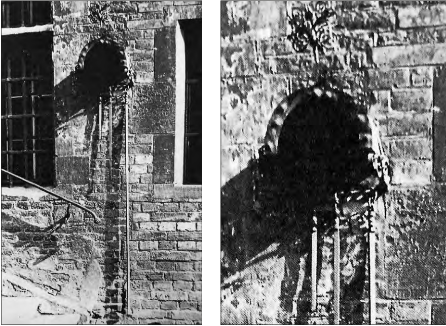
Ryc. 10. Wzorce miar zamocowane na ratuszu Głównego Miasta w Gdańsku. Wycinek przedwojennej fotografii i jej powiększenie. Źródło: Januszajtis 1998, rys. 5.
