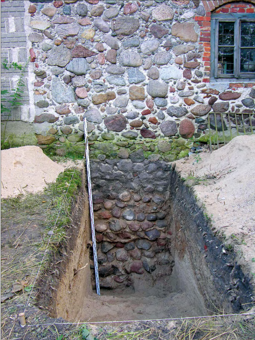
Ryc. 9. Dwór w Górkach Małych – wykop nr I sięgający poziomu posadowienia budowli.
