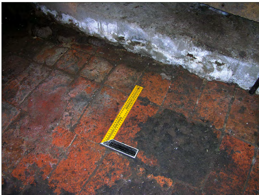
Ryc. 5. Dwór w Górkach Małych – ceglana posadzka w piwnicy.
