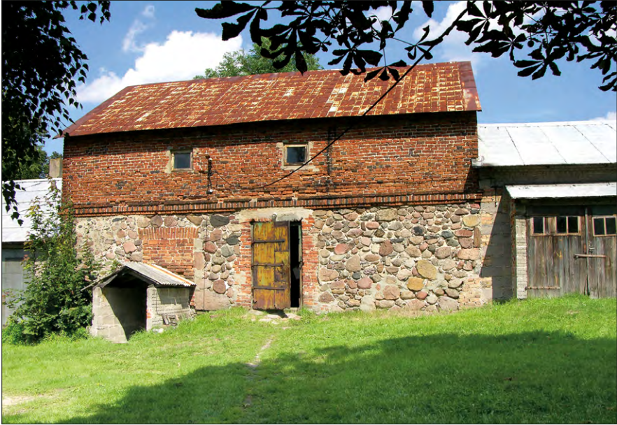
Ryc. 1. Dwór w Górkach Małych – elewacja południowa.
