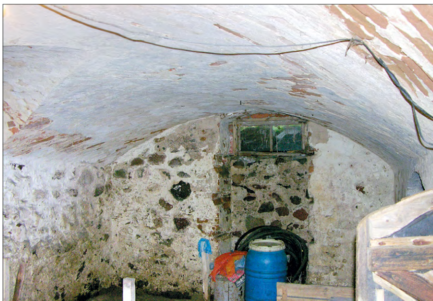
Ryc. 4. Dwór w Górkach Małych – piwnica – mniejsze pomieszczenie.
