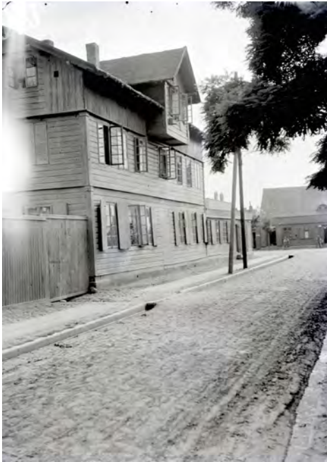
Il. 18. Dom przy ul. Zgierskiej
